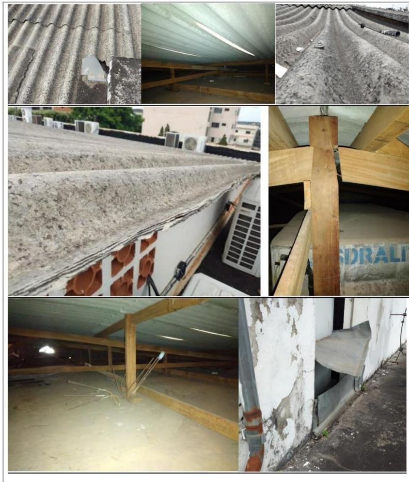
Fig 15. Cobertura em Fibrocimento e Estrutura de Madeira;
