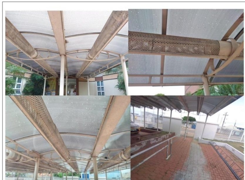
Fig 01. Entrada Principal – Cobertura de entrada em policarbonato;
