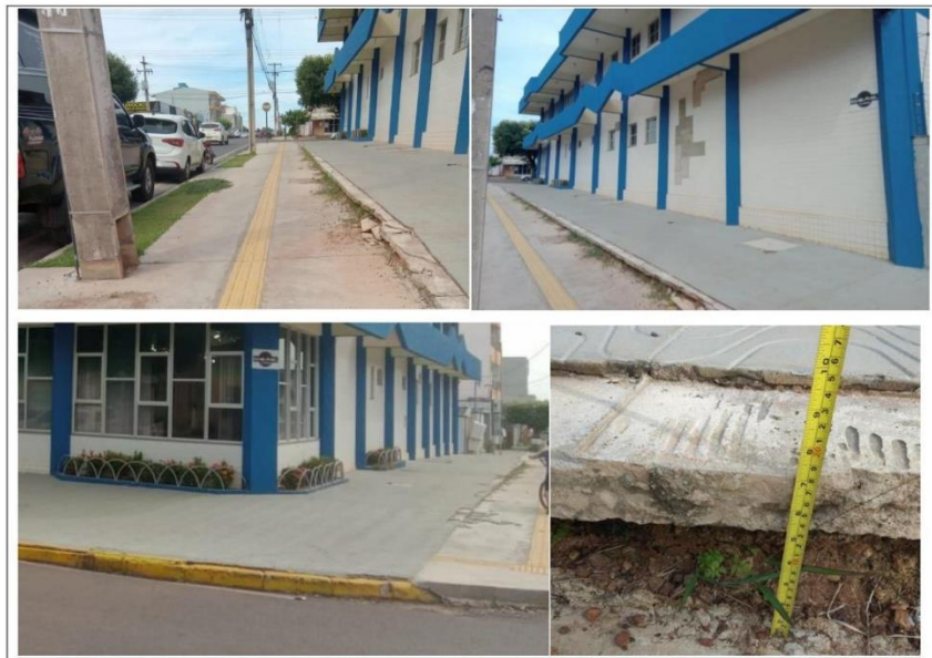
Fig 05. Situação atual das calçadas
