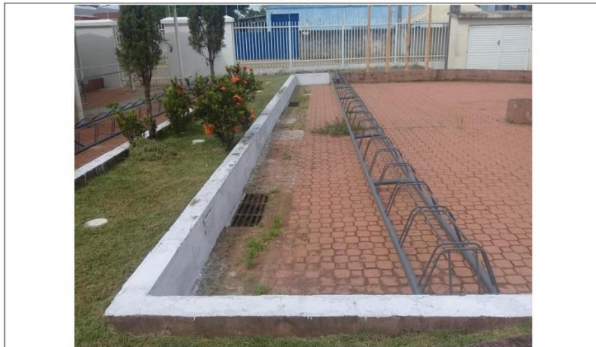
Fig 13. Local onde será implantado o estacionamento;
