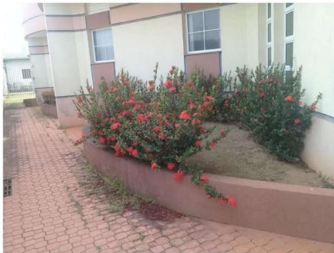
Fig 16. Local onde será feito uma das ampliações da salas.
