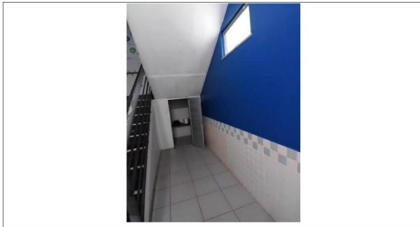
Fig 13. Depósito da Escada – Pav. Térreo.
