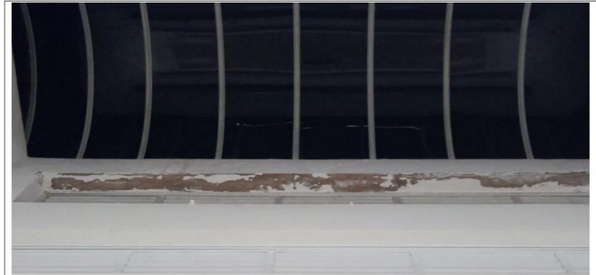
Fig 07. Clarabóia e Coberturas;
