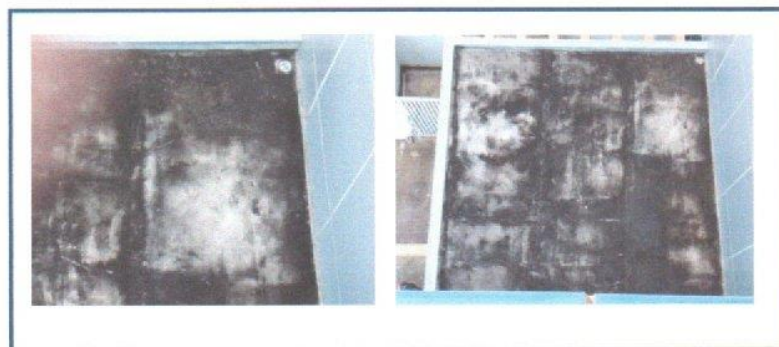
Fig 02. Cobertura da Entrada principal.
