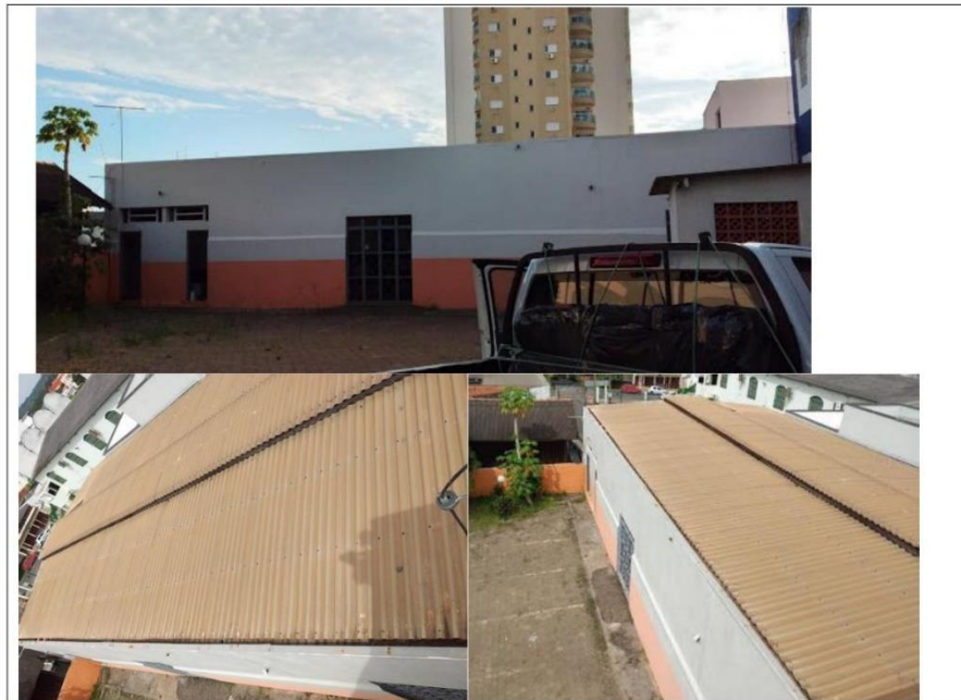
Fig 03. Depósito atual onde haverá intervenção;
