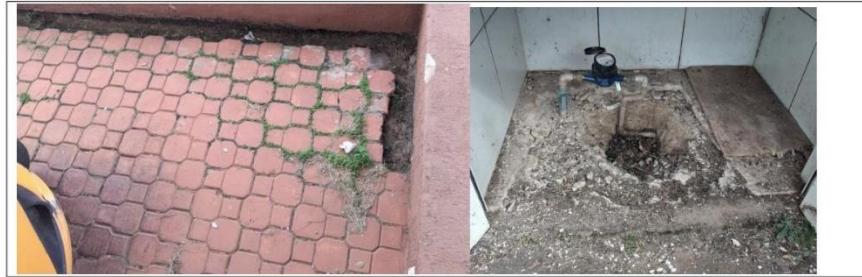
Fig 12. Reparo e pintura em piso intertravado e remanejamento de medidor de águas.
