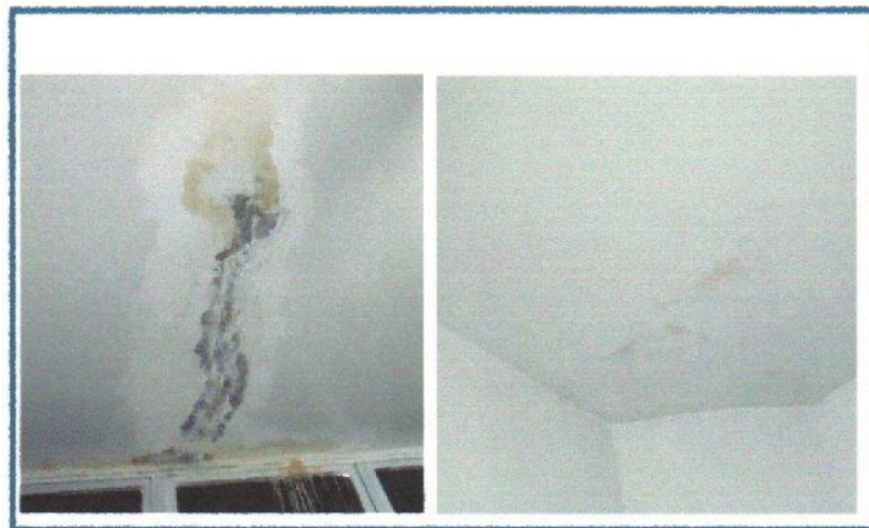
Fig 05. Forro em laje da sala de estética.
