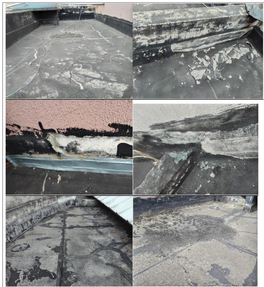
Fig 05. Laje da Edificação;
