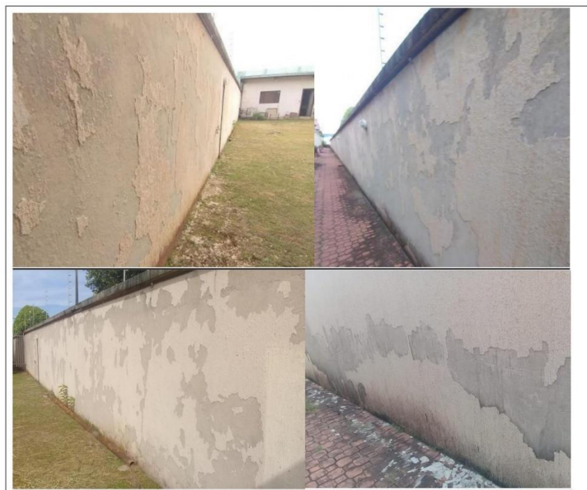
Fig 04. Situação atual dos muros.
