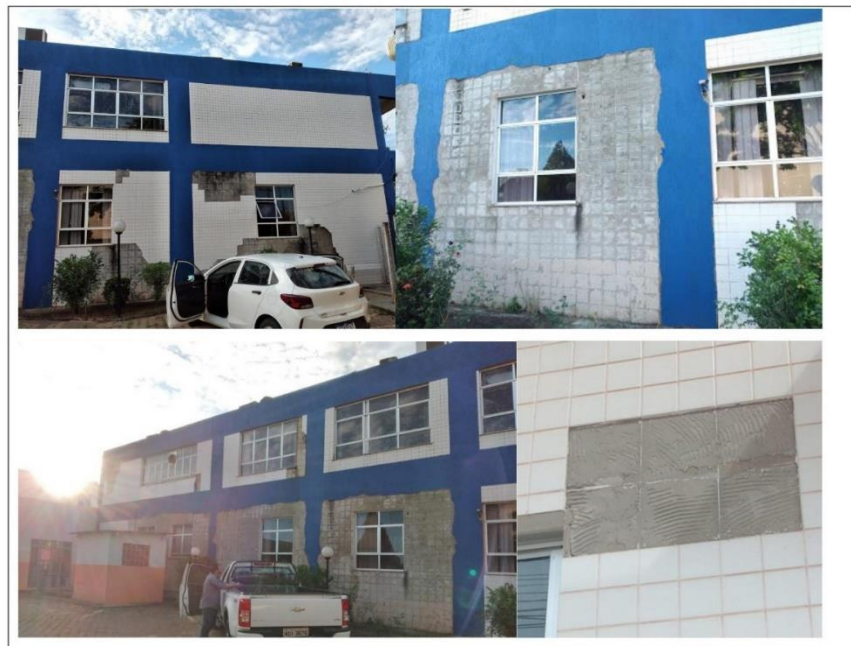
Fig 02. Fachada lateral esquerda.
