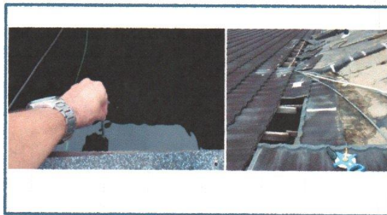
Fig 08. Cobertura em laje – Sala de estética e Marquise;
