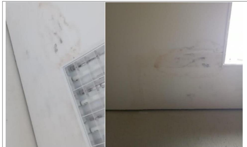
Fig 10. Forros de gesso interno e externo;
