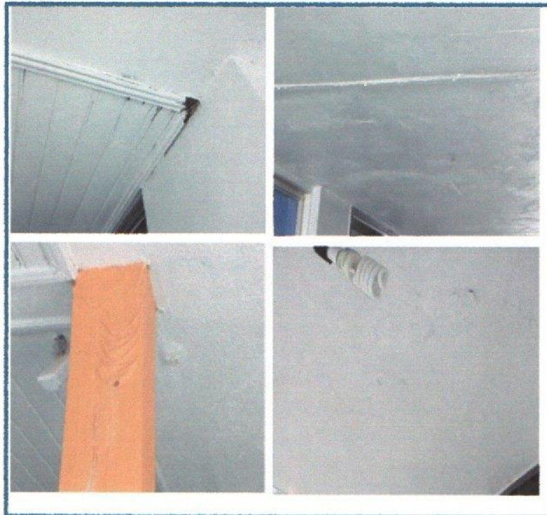
Fig 01. Corredor de Entrada – Forro e Cobertura;
